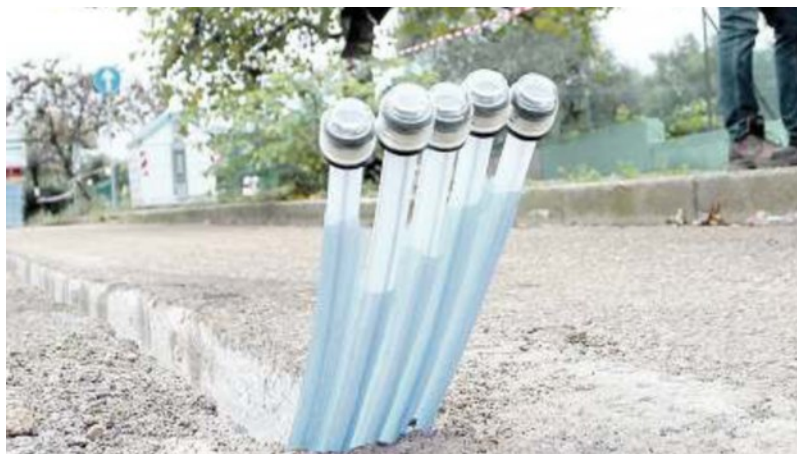
Lavori per installare cavi in fibra ottica
