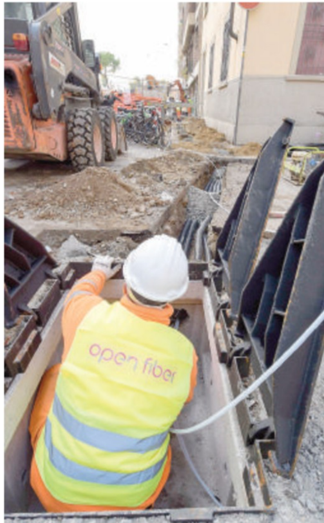
Lavori di scavo per la posa della fibra ottica
