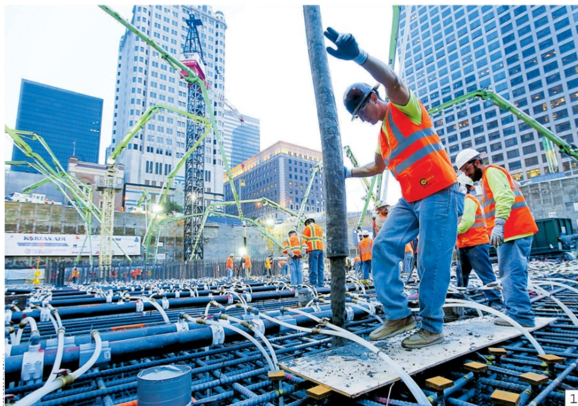
Operai edili lavorano con un braccio robotico usato per posare con precisione il cemento
