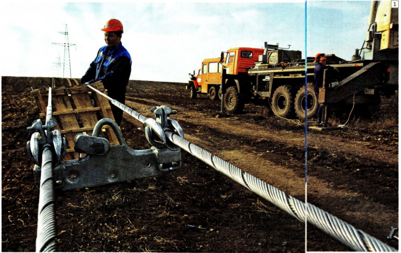
1 Una linea elettrica HvdC in costruzione in Crimea
