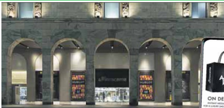
Lo sede della Rinascente a Milano. A destra, il servizio on demand
