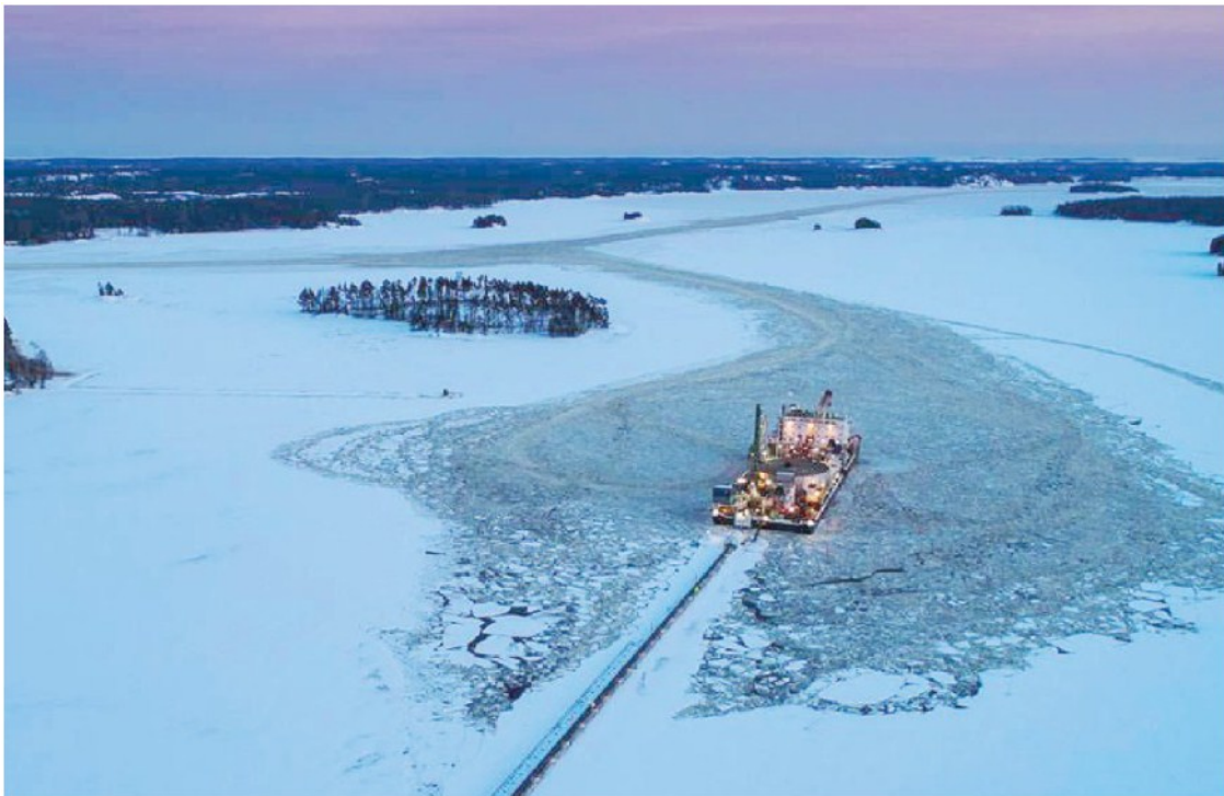
Il progetto WesternLink. Un momento della posa dei cavi sottomarini tra Scozia e Inghilterra da parte di Prysmian
