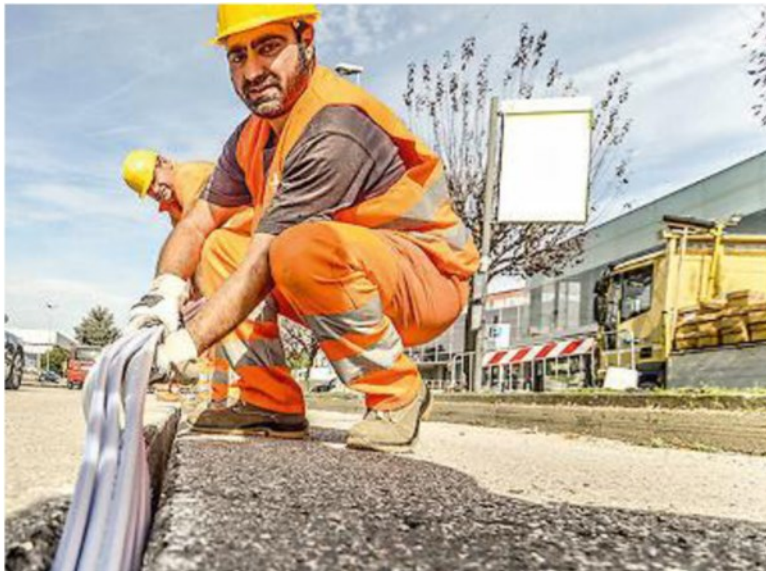
AL LAVORO Via a 2mila nuovi cantieri per la banda ultralarga
