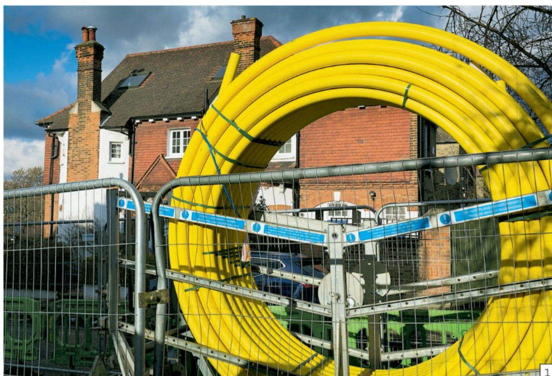
Un'immagine della posa di una nuova condotta per la distribuzione del gas in una strada residenziale a Lambeth, un borgo della città di Londra
