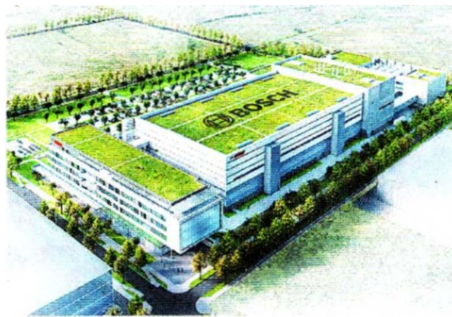
Il progetto del Wafer Fab RB300 che sta prendendo vita a Dresda per la produzione di semiconduttori. Si tratta di un esempio di industria 4.0
