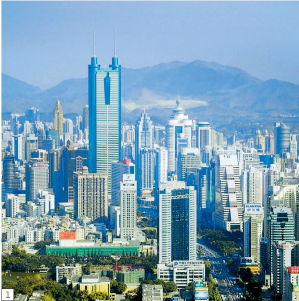
1 Lo skyline ultra moderno di Shenzhen con il Diwang Building: oggi la metropoli conta 11 milioni di abitanti
