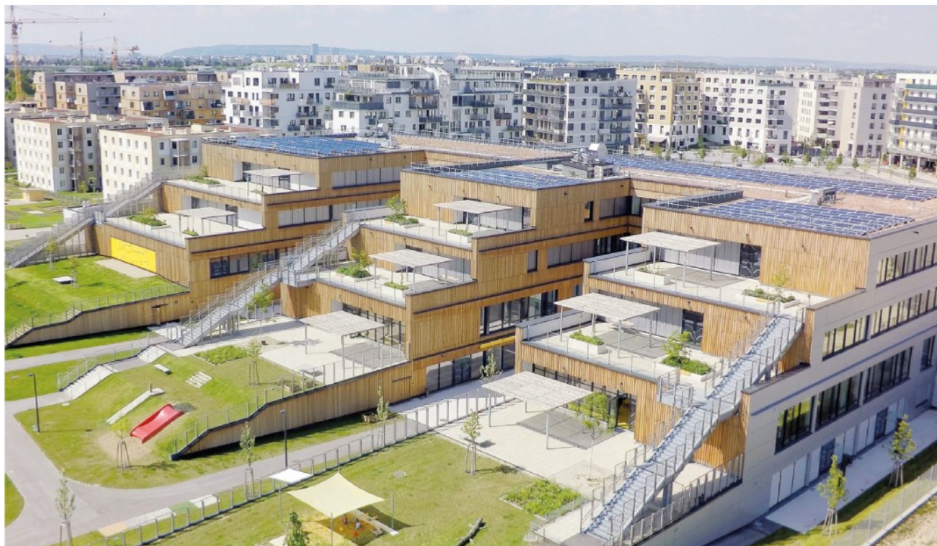
Strutture flessibili. Il quartiere di Aspern, alla periferia di Vienna, è un esempio di integrazione e connessione tra rete elettrica, cittadini ed edifici intelligenti
