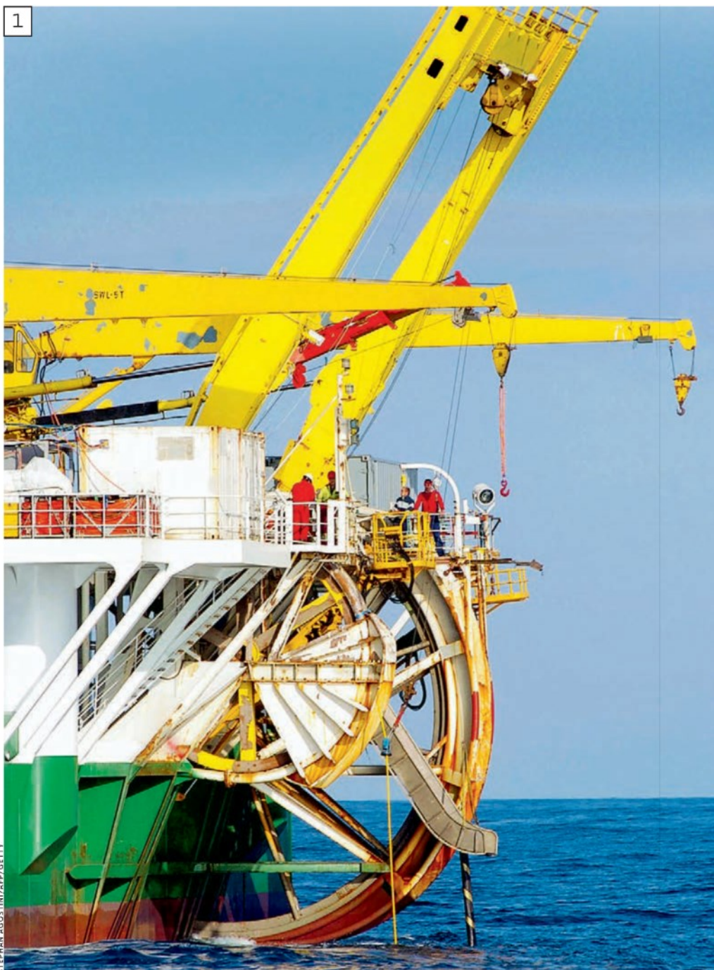
1 Una nave posa cavi sottomarini all'opera al largo della costa sarda, davanti a Santa Teresa di Gallura
