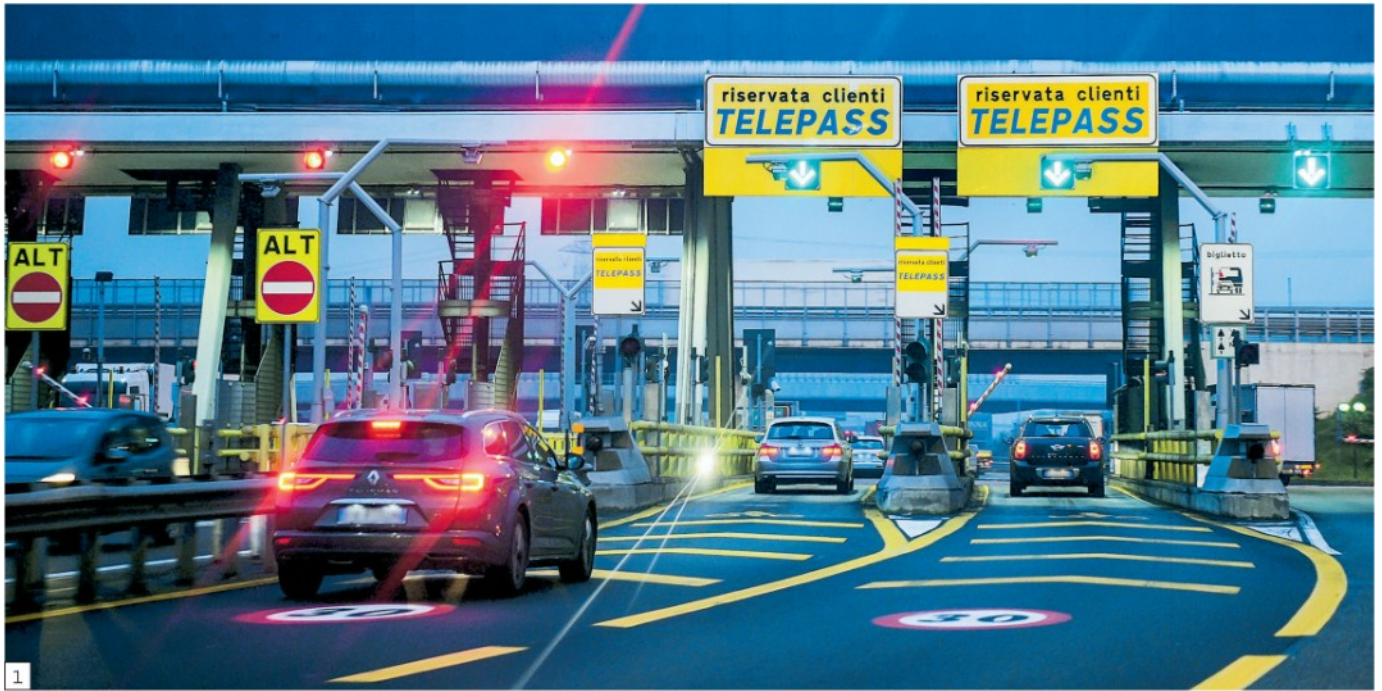
1 Uno dei caselli autostradali con le corsie riservate al pagamento del pedaggio con Telepass. Con il completamento della liberalizzazione saranno ammessi anche dispositivi forniti da altri operatori
